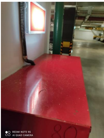
Влажная протирка пожарных шкафов
