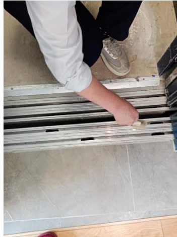
Ручная прочистка углублений дверей лифтовых кабин
