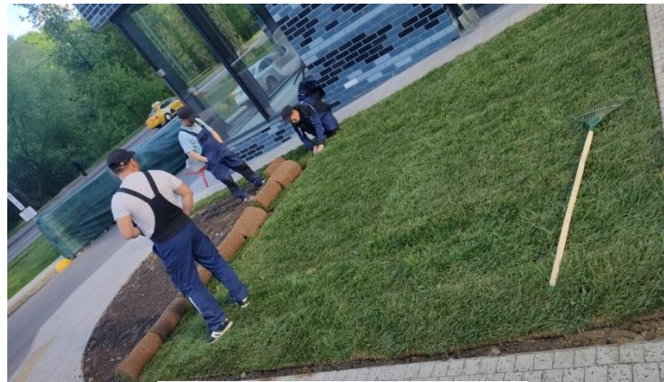
Укладка нового газонного покрытия
